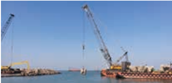
Breakwater under construction at Dabhol LNG Terminal
