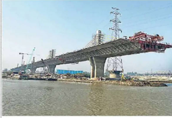
निर्माणाधीन सिक्सलेन पुल
