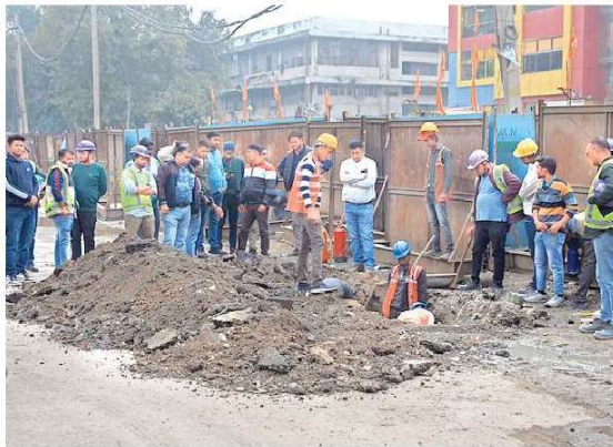
जीटी करनाल रोड पर लाल बाग के पास रोड की खोदाई कार्य के कारण फटी आइजीएल पाइप लाइन के मरम्मत कार्य में जुटे कर्मचारी
