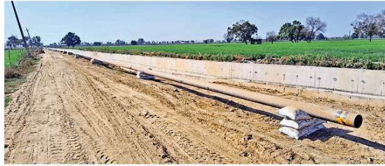
एयरपोर्ट के सीएनजी स्टेशनों को जोड़ने को डाली जा रही गैस की पाइपलाइन • जागरण
